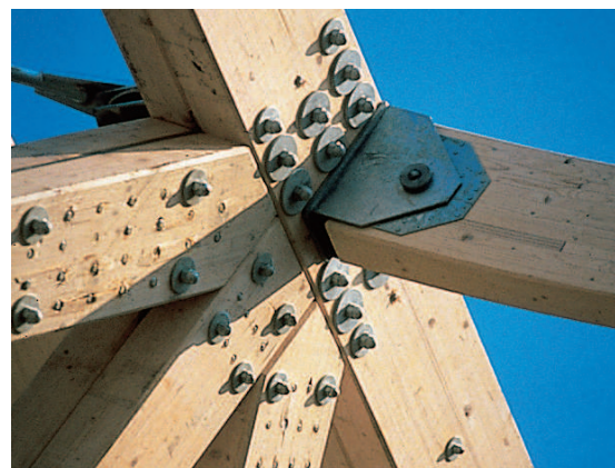
Knoten mit Stabdübeln und Bolzen
