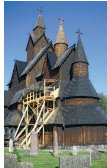
Die Heddal-Stabkirche in Norwegen, erbaut bereits um 1250 n. Chr. Bei Bedarf werden lediglich Dachschildeln ersetzt, um Feuchteschäden zu vermeiden
