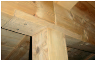
Die höhere Querdruckfestigkeit des Laubholzes wurde an dieser Dachpfette ausgenutzt
